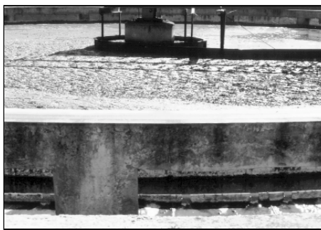
Digestores primarios. Los residuos son retirados con una especie de pala gigante y por abajo sale el agua tras un primer proceso de depuración.
