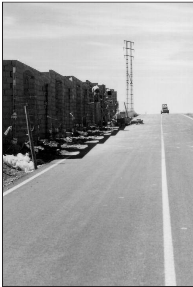
Las constructoras aprovechan ya la expansión urbanística que supone la vía para construir viviendas
