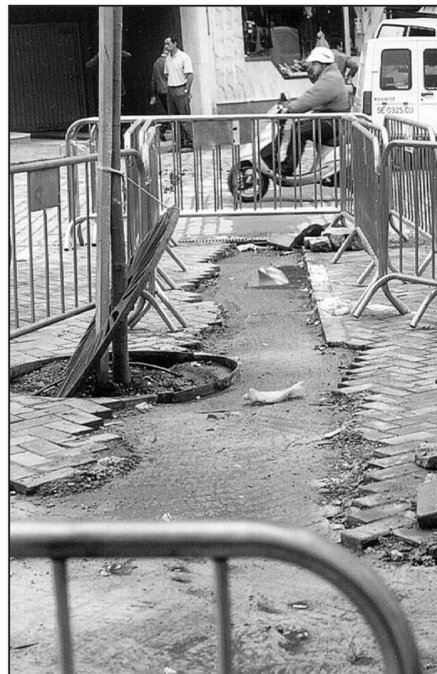
Obras para la instalación del gas en la zona centro.
