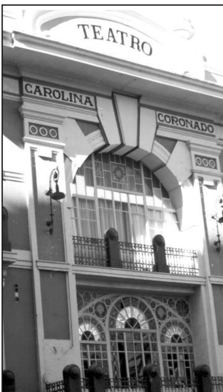
Fachada del Teatro Carolina Coronado.
