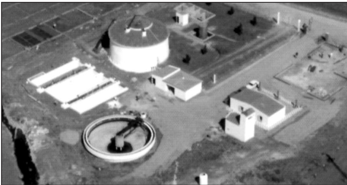
Depuradora que utilizarán los aceituneros para canalizar los vertidos.
