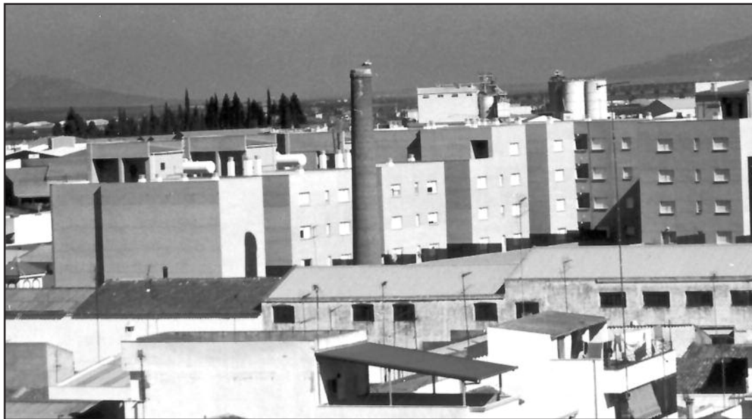
Chimenea situada en el edificio Alambique.
