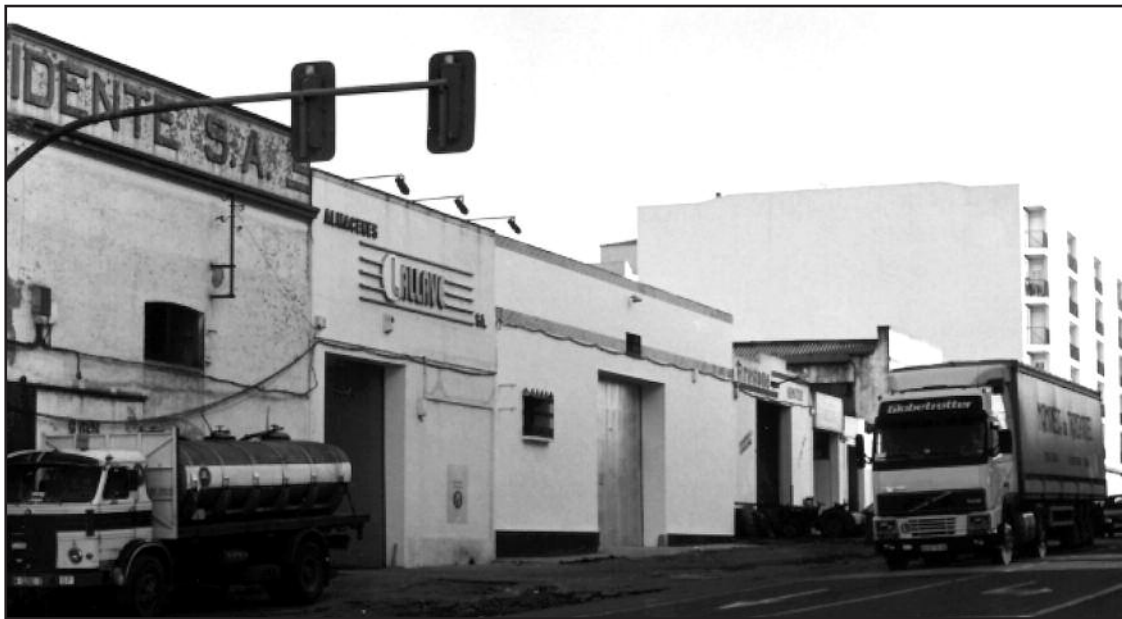
Semáforos de la Carretera N-630 a su paso por Almendralejo
