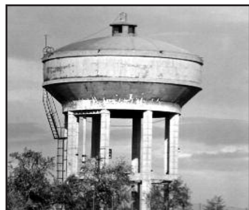
Depósito de carretera de la Fuente
