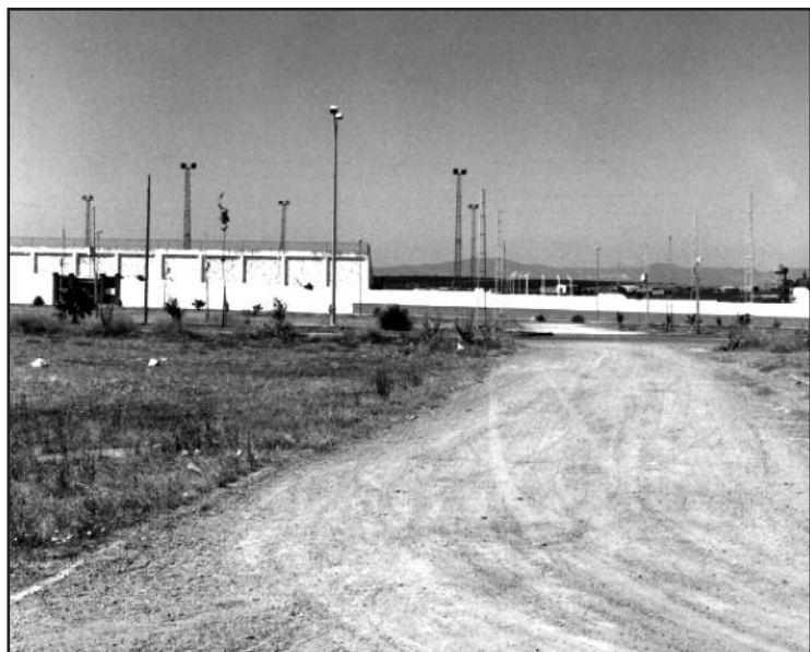
Recinto ferial junto al Polideportivo
