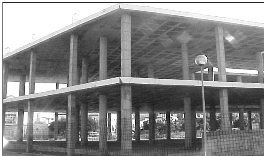
Una de las viviendas en construcción en el PERI
