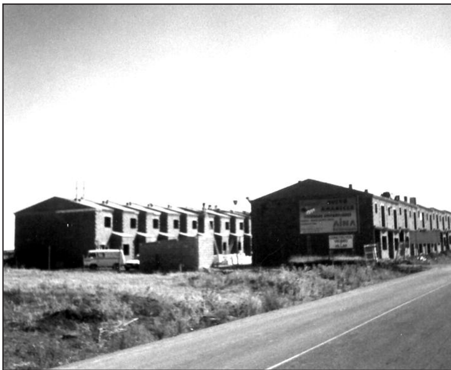
Viviendas en construcción en la Ctra. de circunvalación cruce con Ctra. Aceuchal
