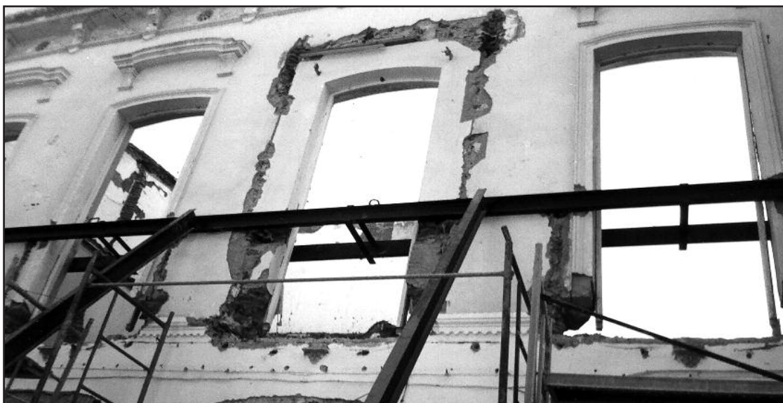
Fachada de la calle Cervantes antes de ser demolida
