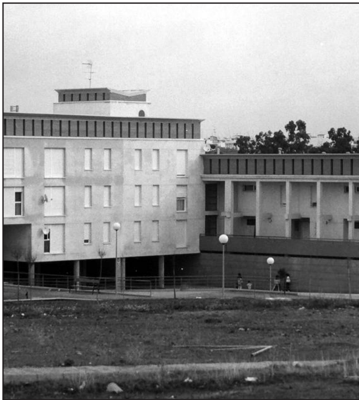
Viviendas sociales afectadas por el temporal
