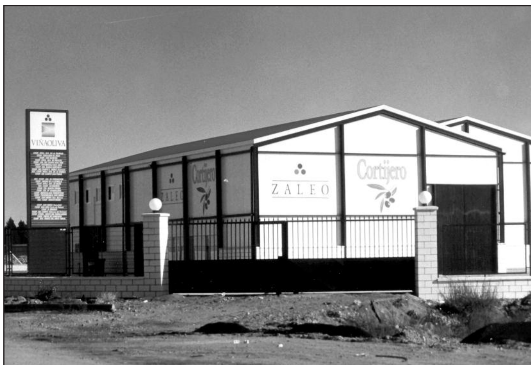
Instalaciones de Viñaoliva en el polígono industrial
