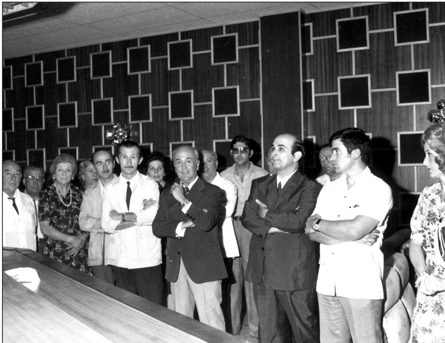
En 1975, el entonces alcalde D. Tomás de la Hera, inaugura la confitería Delgado después de ser remodelada
