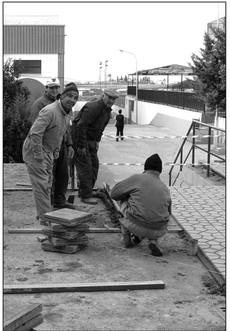
Operarios trabajando en el Polideportivo Municipal
