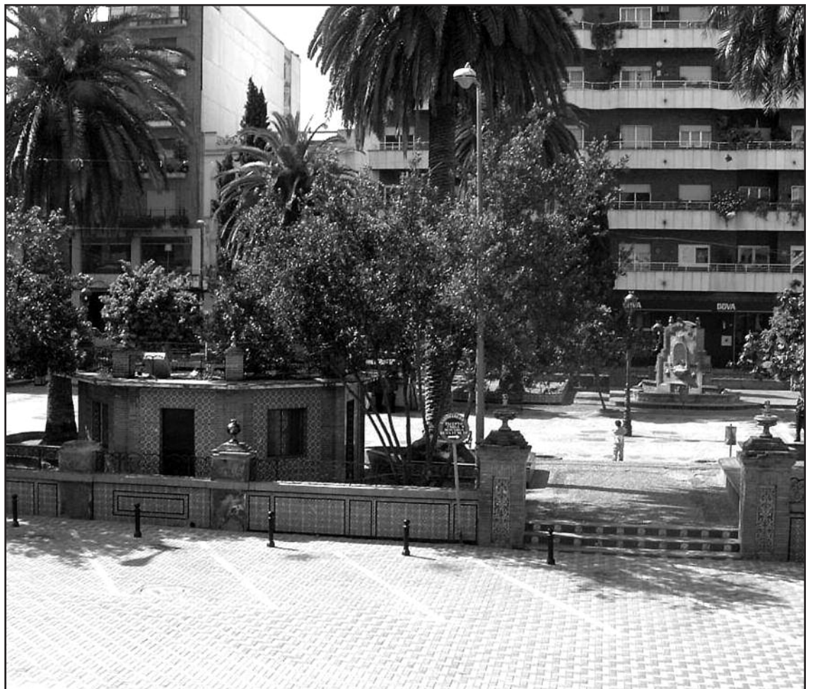
El Parque de Espronceda antes de comenzar la obra
