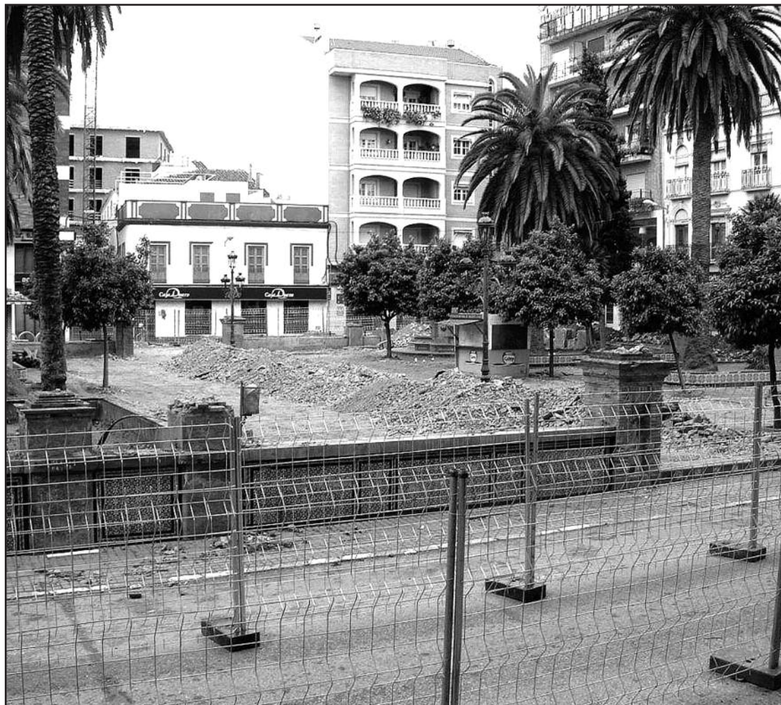
La obra en el Parque de Espronceda ya está en marcha
