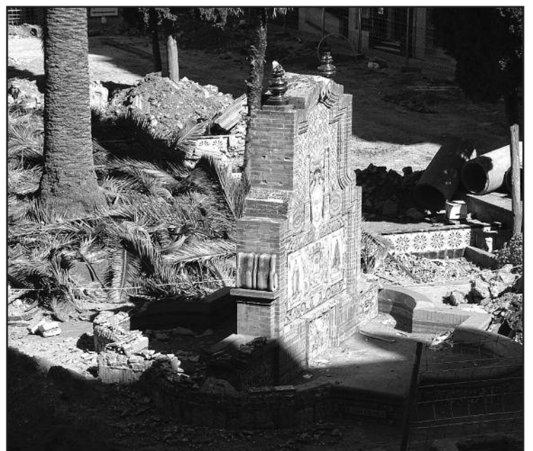
Obras de la Plaza de Espronceda
