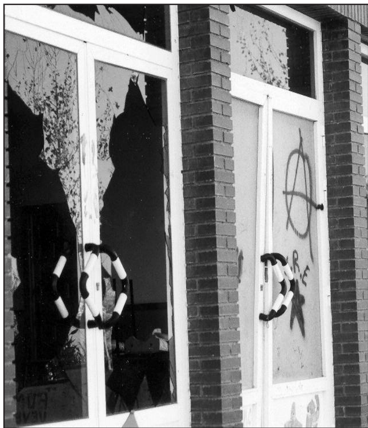
Estado actual de la cafetería del Parque de las Mercedes
