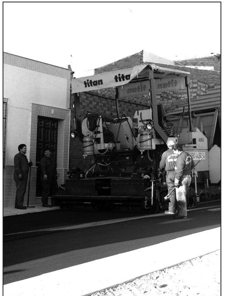
Operarios trabajando en el asfaltado de calles
