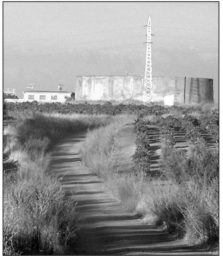
Depósito de agua junto al Camino Calerizo
