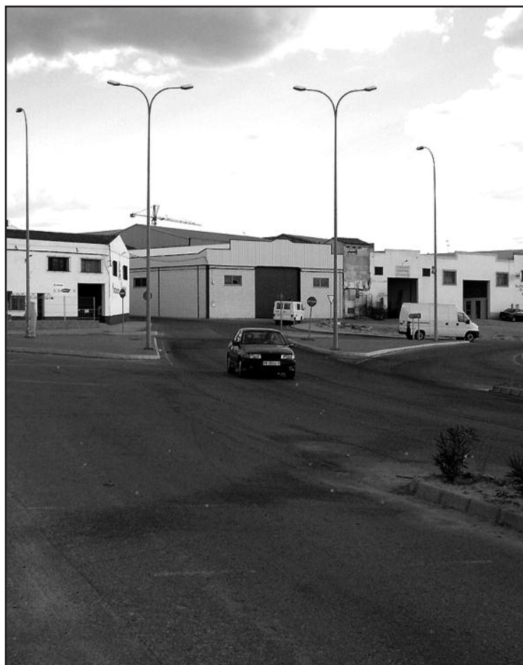
Cruce de la carrera de Arroyo donde se construirá una rotonda
