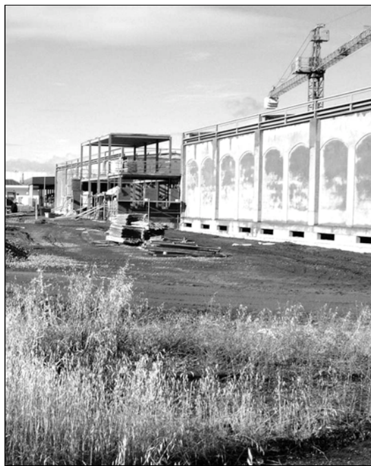
Obra del recinto ferial
