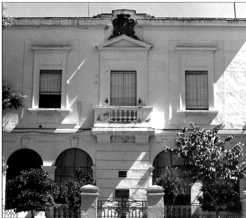
Fachada del colegio San Antonio
