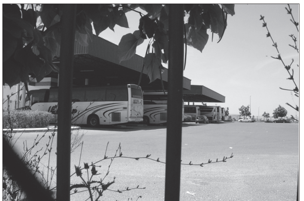
La consejería de Infraestructuras, Transporte y Vivienda da por finalizadas las obras de mejoras de accesibilidad en la estación de autobuses de Almendralejo y las de Don Benito, Villanueva de la Serena y Mérida, tras una inversión total de algo más de 700.000 euros
