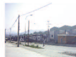
2ª NAVES (PLASENCIA)
