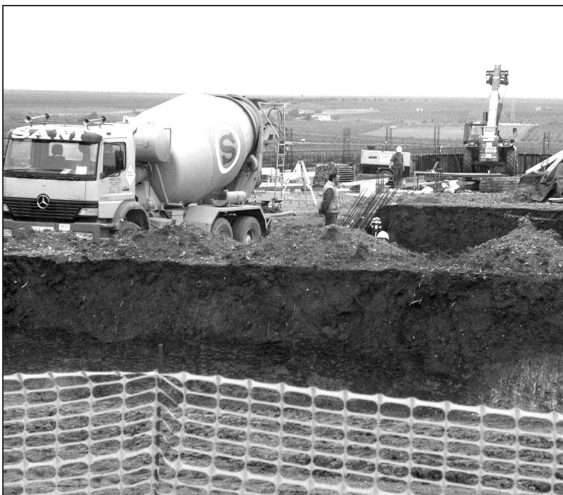
Primeros trabajos de la obra del Hospital
