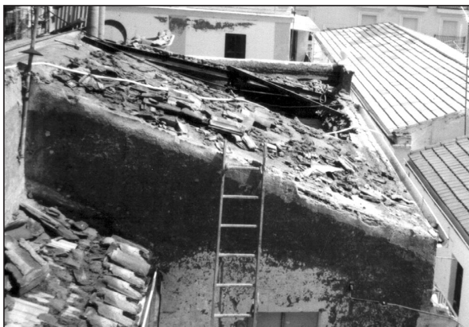
Estado del techo antes de la reforma
