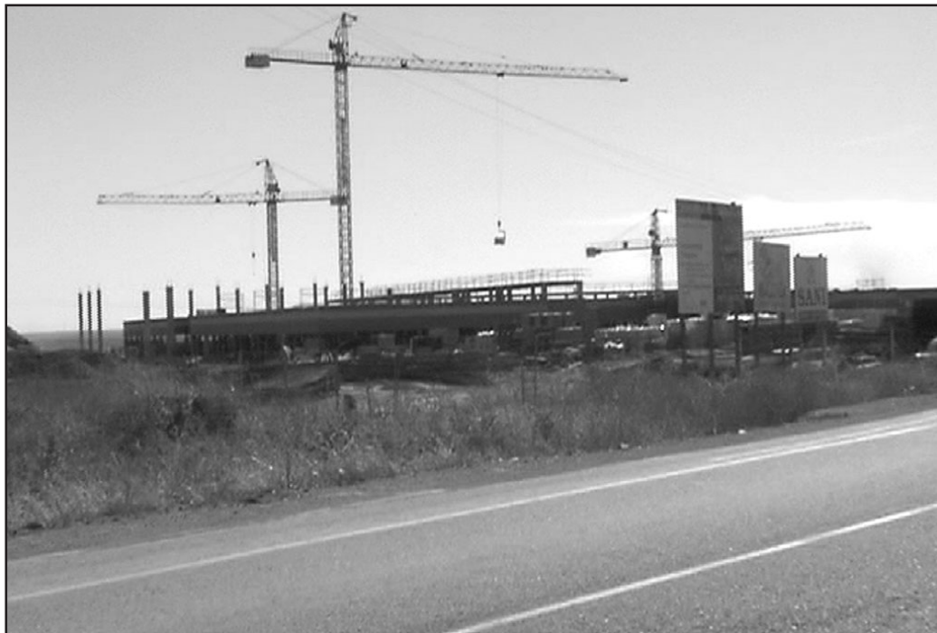
El Hospital estará terminado a finales de 2005
