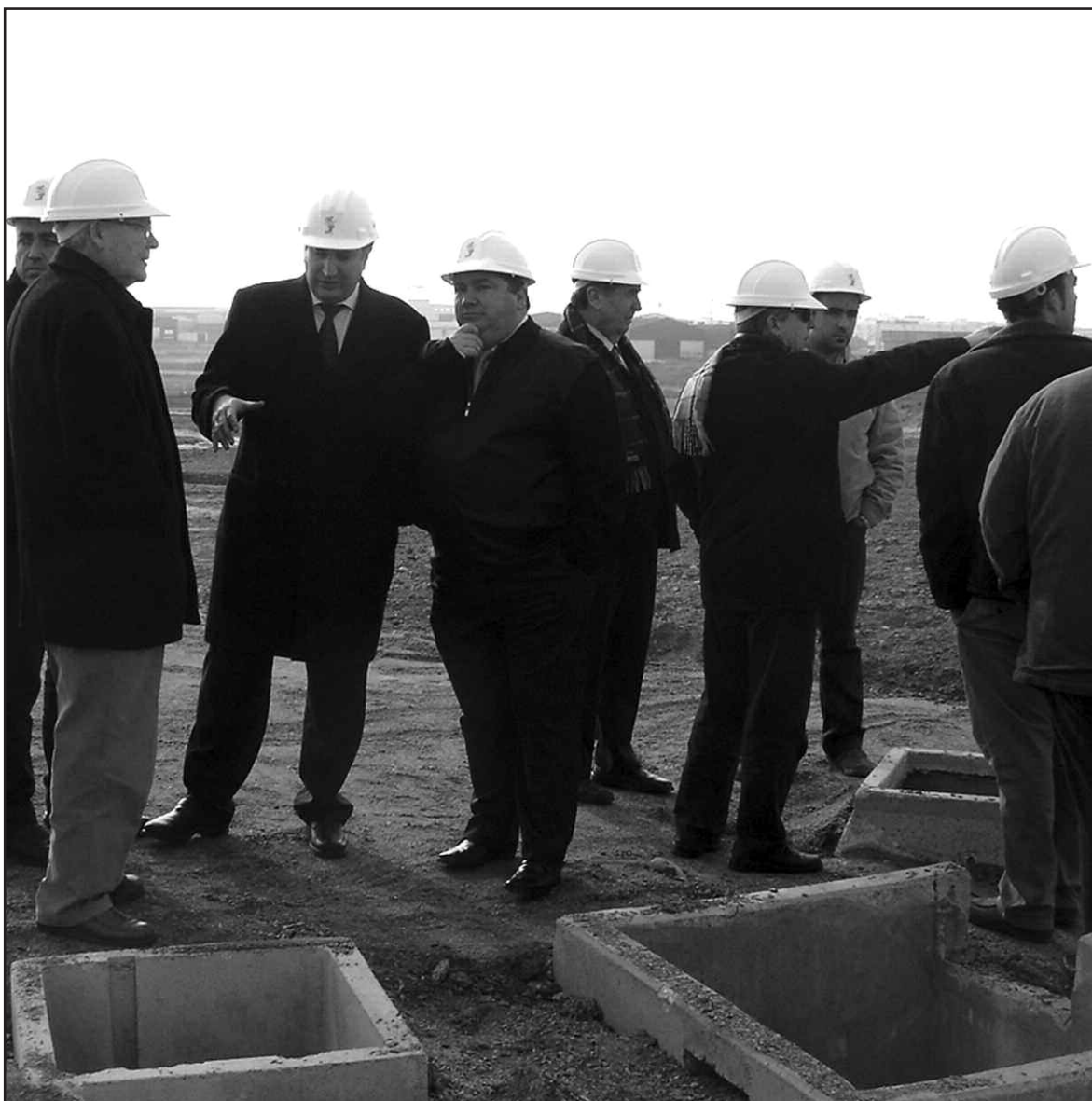
El director de Promoción Industrial visitó las obras de ampliación del polígono industrial
