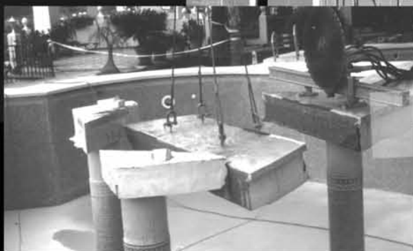
Máquina corte muro hormigón
