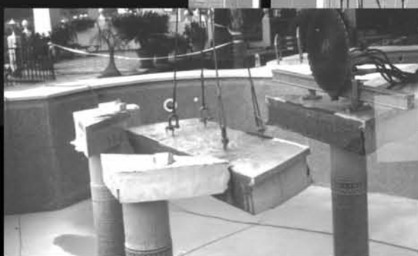
Máquina corte muro hormigón
