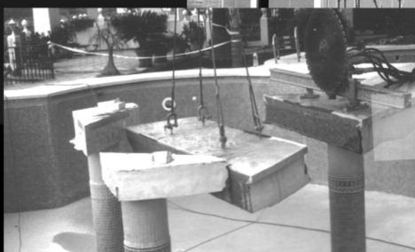
Máquina corte muro hormigón
