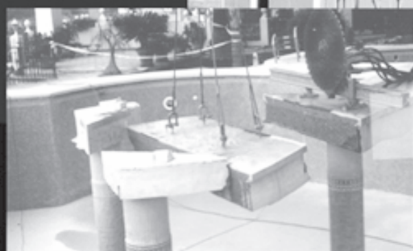
Máquina corte muro hormigón
