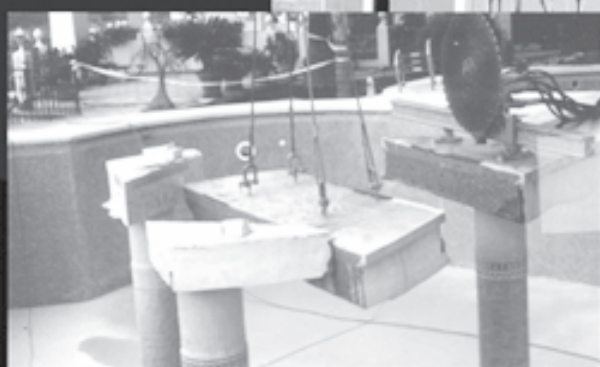
Máquina corte muro hormigón
