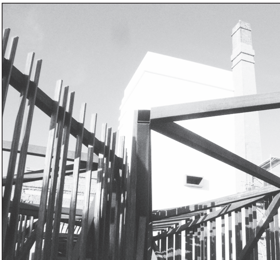
Obras del Museo del Vino
