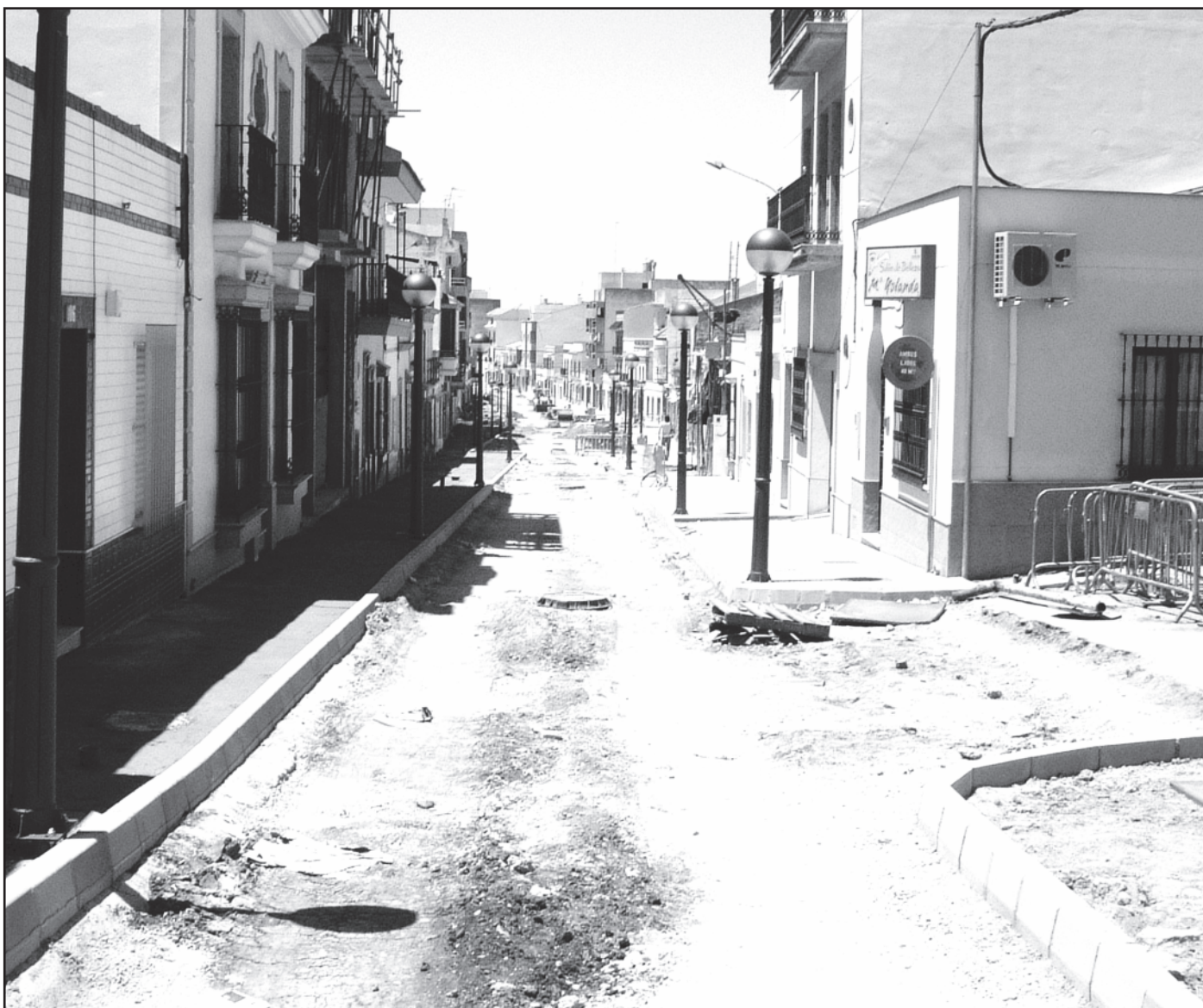
Los vecinos se quejan de que no se solucionara el problema cuando se reformó la calle
