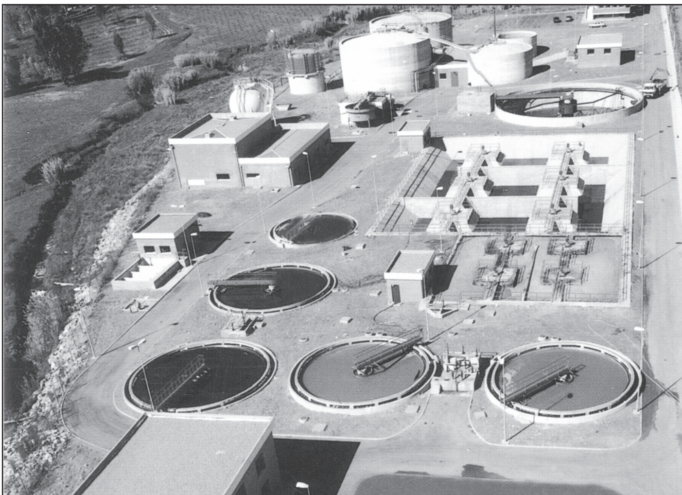
Depuradora de aguas residuales
