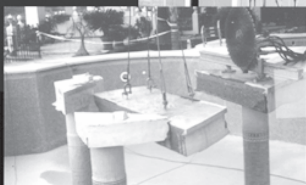
Máquina corte muro hormigón
