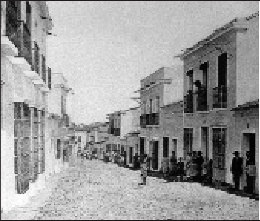
En su mandato cambio la denominación de la calle Escusada por calle San José
