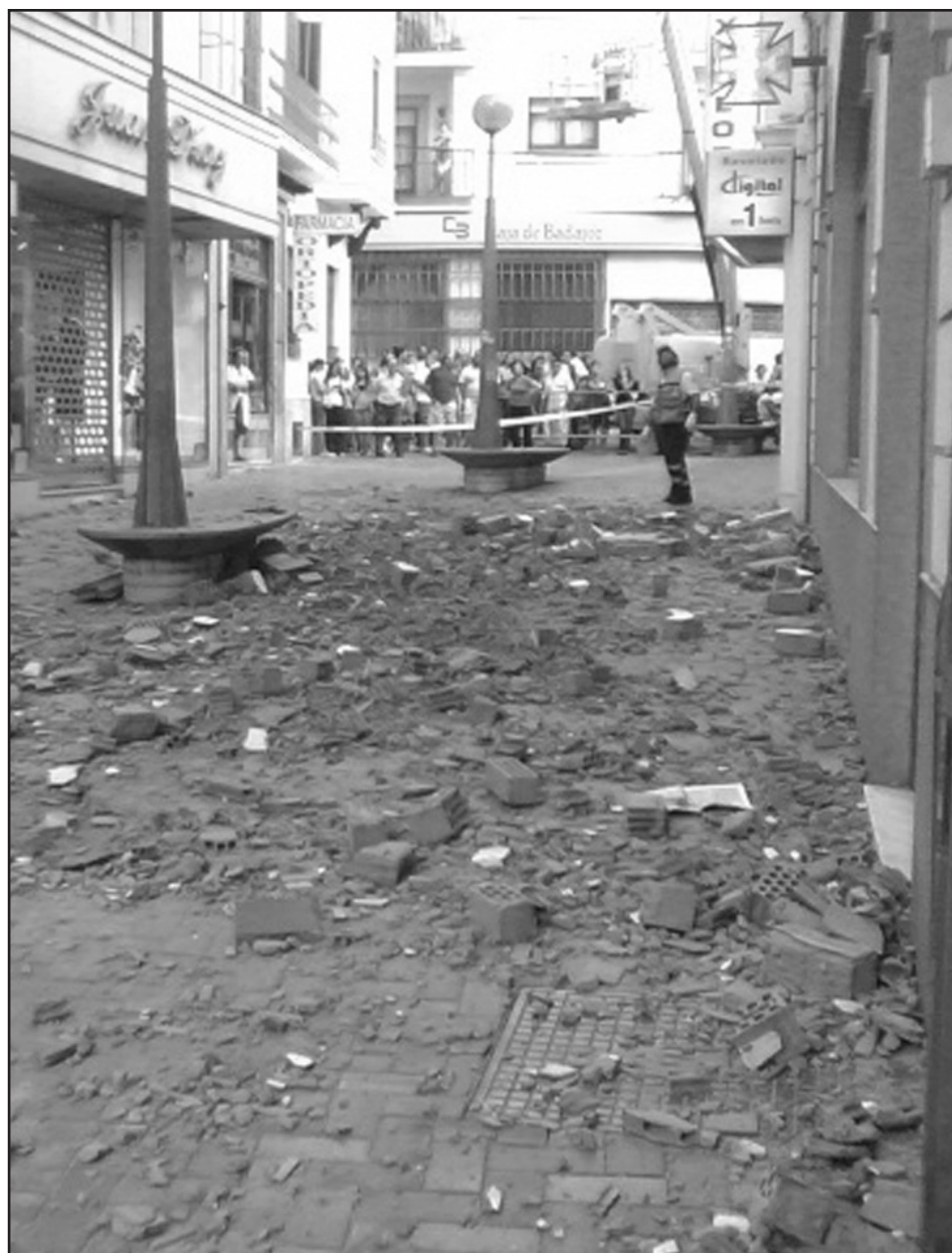
Así quedó la calle Real tras el derrumbe de la cornisa
