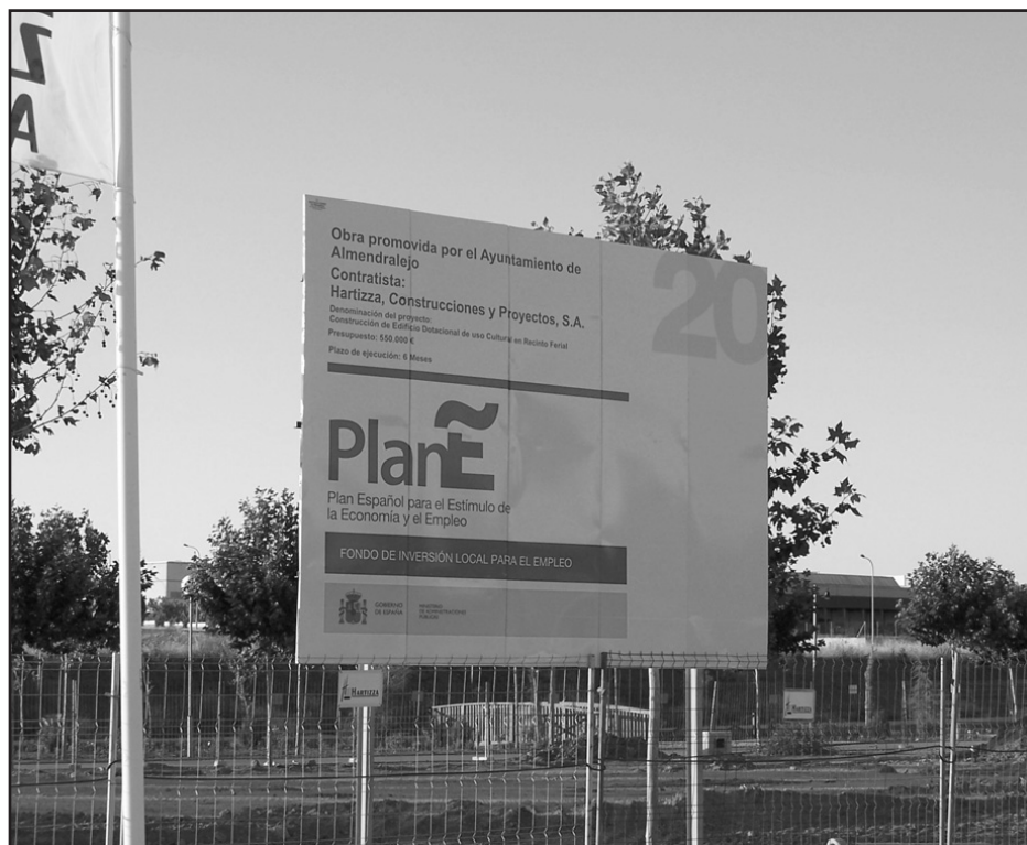
Construcción de un edificio dotacional en el recinto ferial
