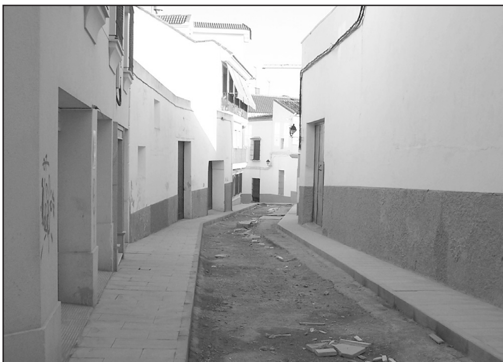
Obras en la calle Judería
