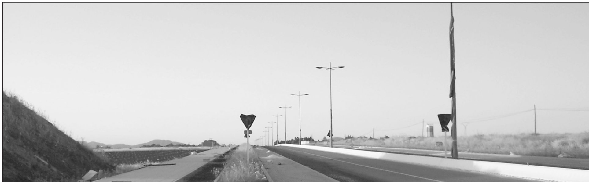
La gran obra en ejecución es la travesía de la N-630
