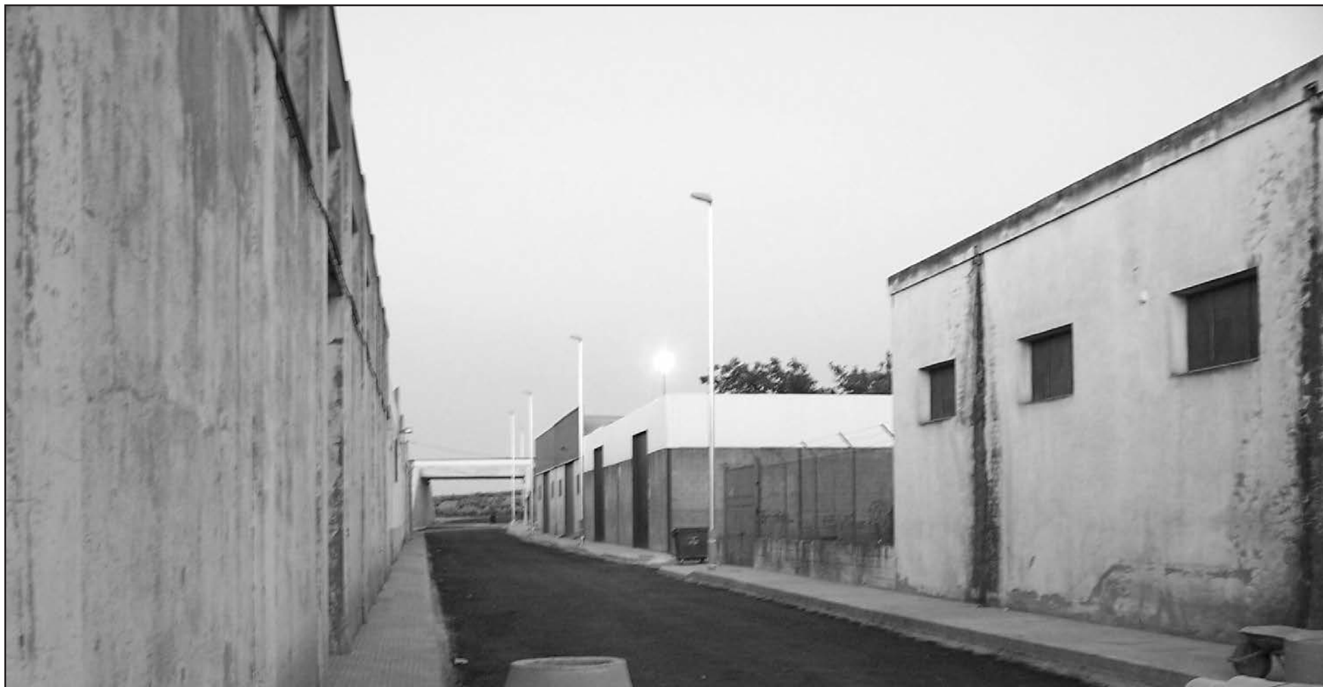
A la calle se le ha echado una capa de rodadura
