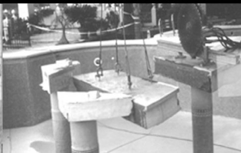
MÁQUINA CORTEMURO DE HORMIGÓN
