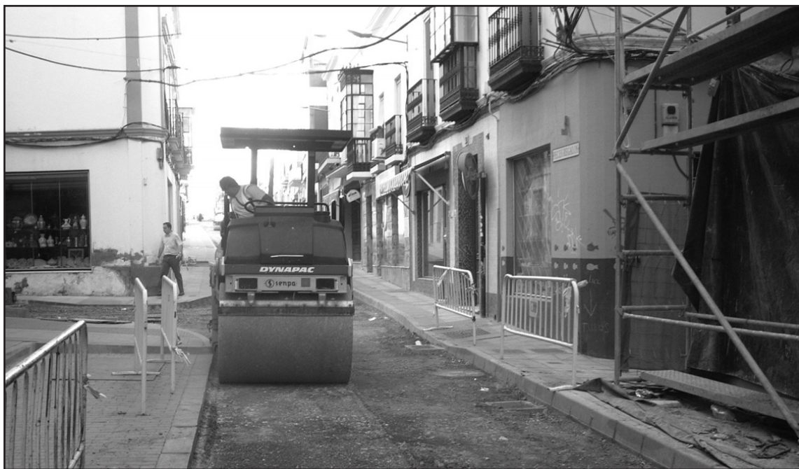
La obra de la calle Mártires está prácticamente concluida
