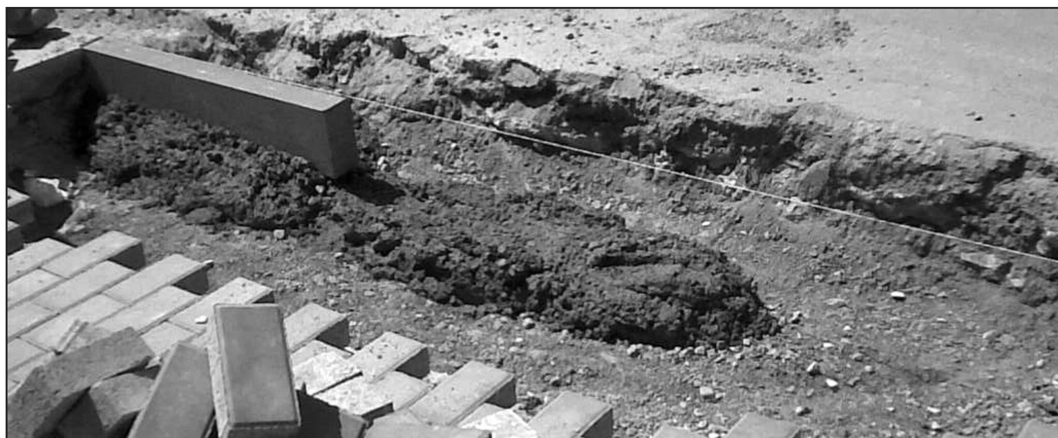
En este mes, dice Forte, estará concluida la obra
