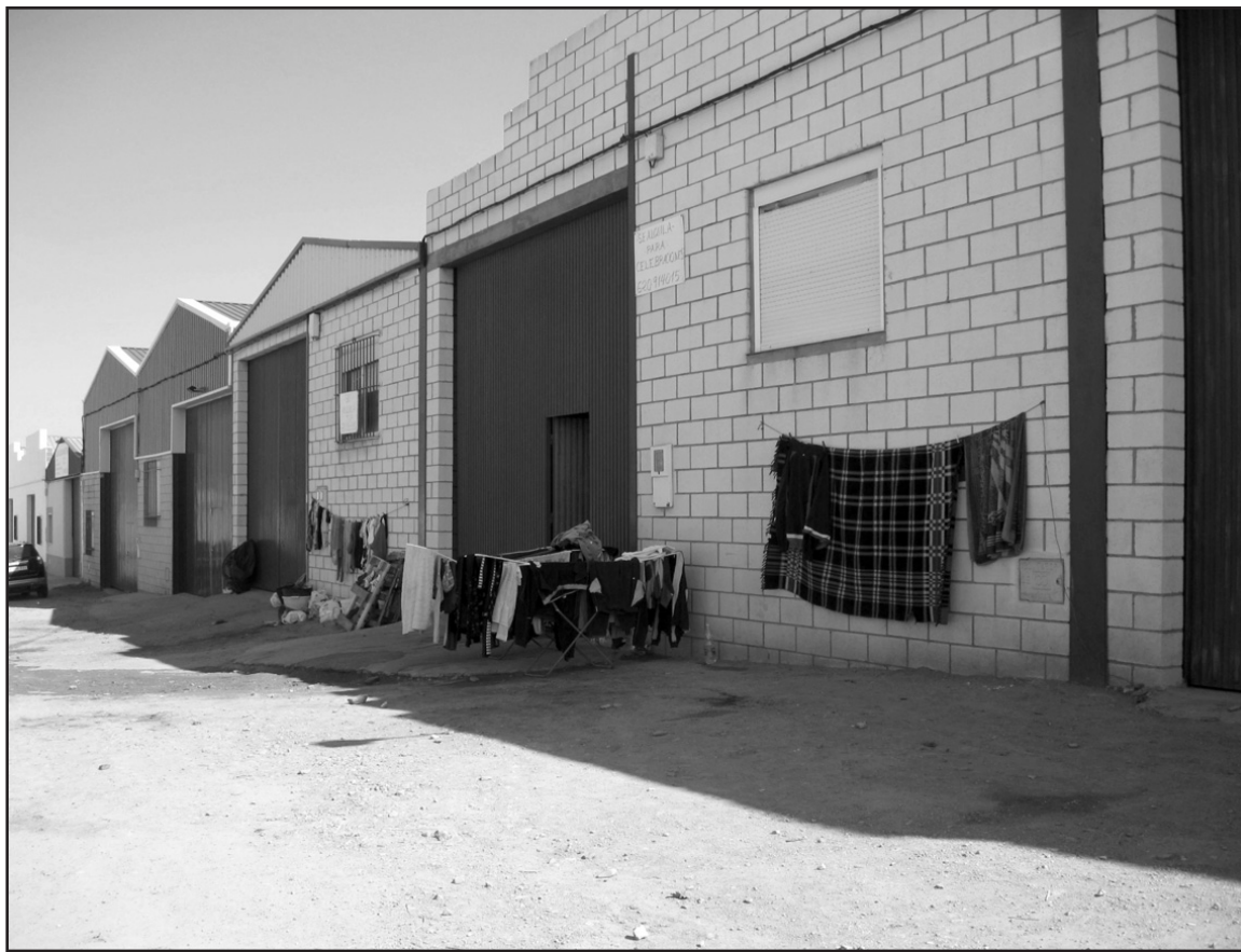
Aspecto exterior de una nave en la que residían inmigrantes rumanos
