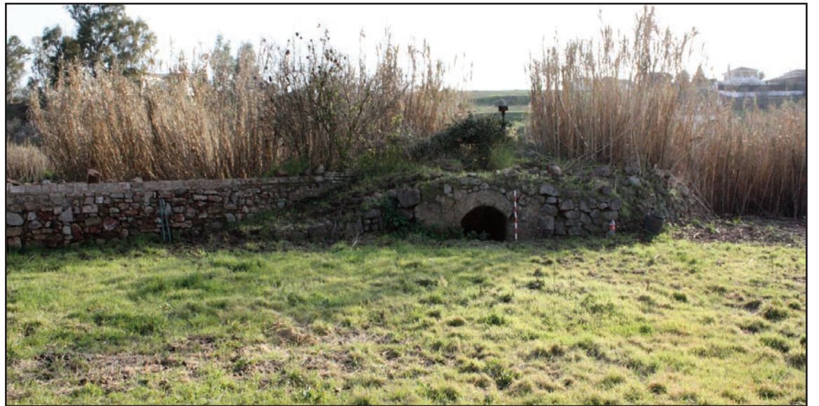
Antigua noria con su acequia en las inmediaciones de Los Cañitos. Enero de este año
