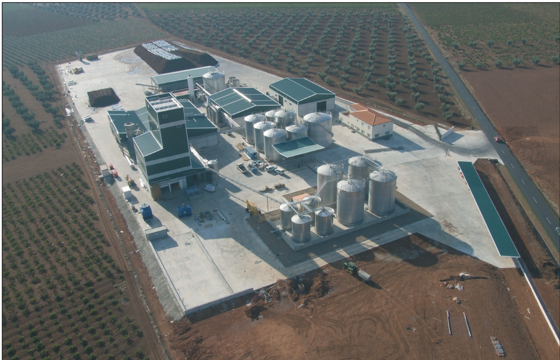
Instalaciones de la nueva alcoholera de Viñaoliva
