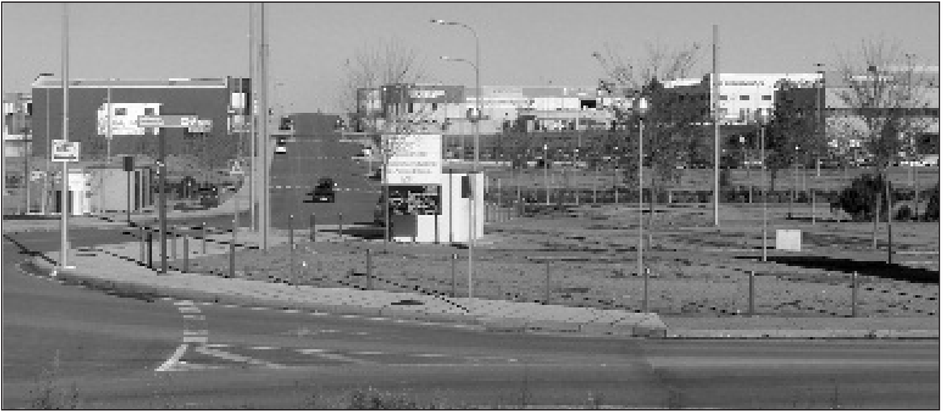
Polígono industrial "Las Picadas II"
