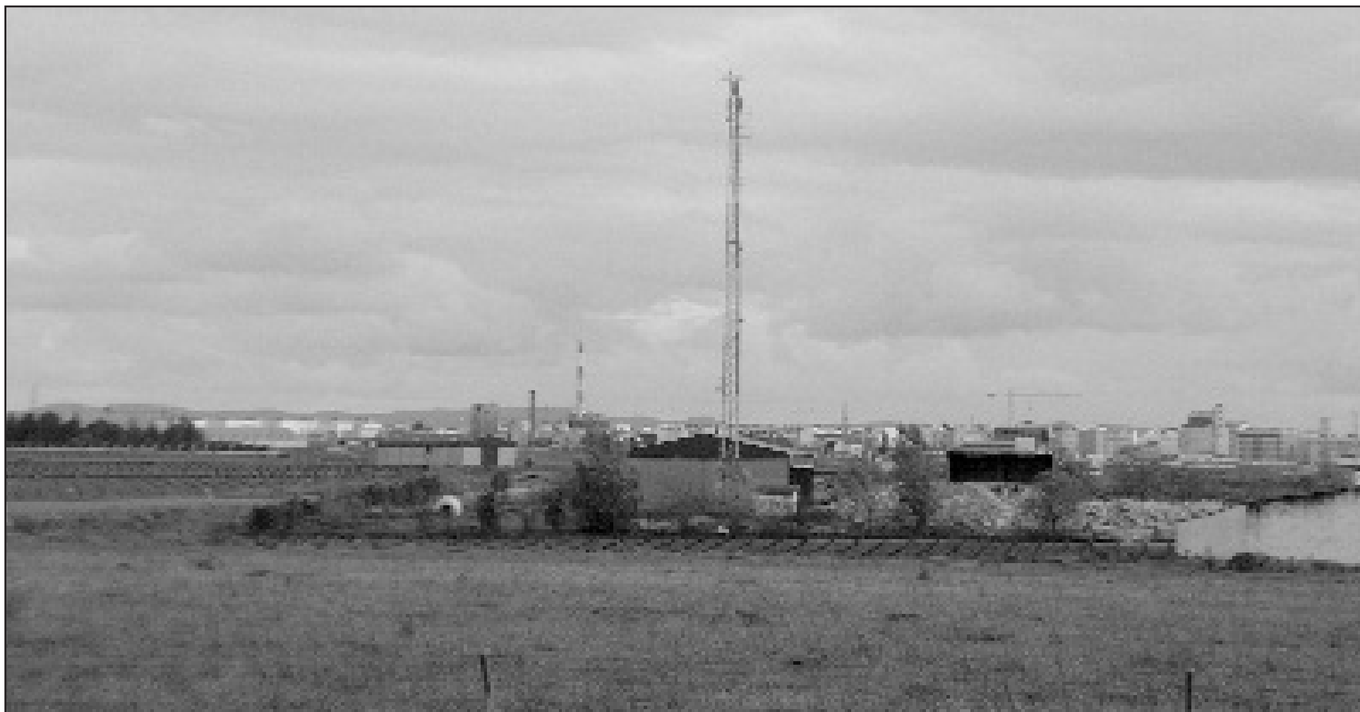
Antena municipal, en unos terrenos próximos a la Avenida de Europa
