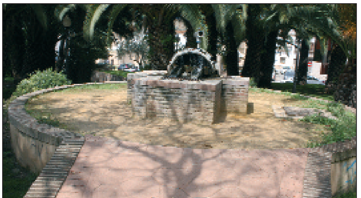
Cuerpo principal de noria rehabilitada (Parque de Santa Clara)
