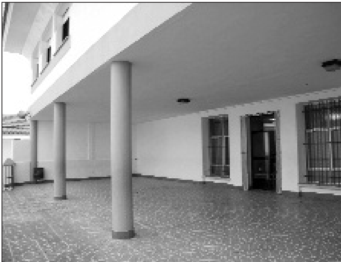
En este porche se construirá una nueva aula
