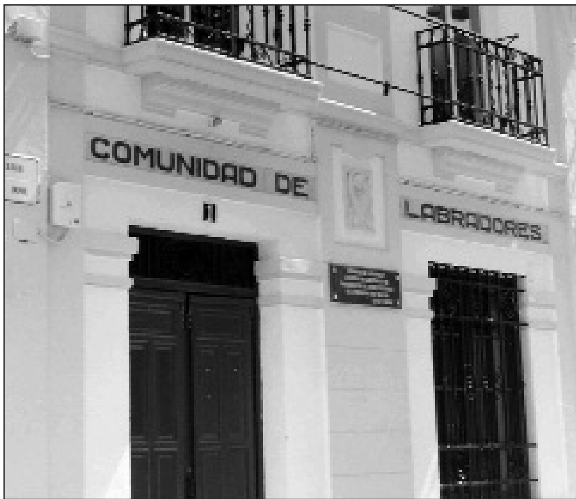
Sede de la Comunidad, en la calle San José
