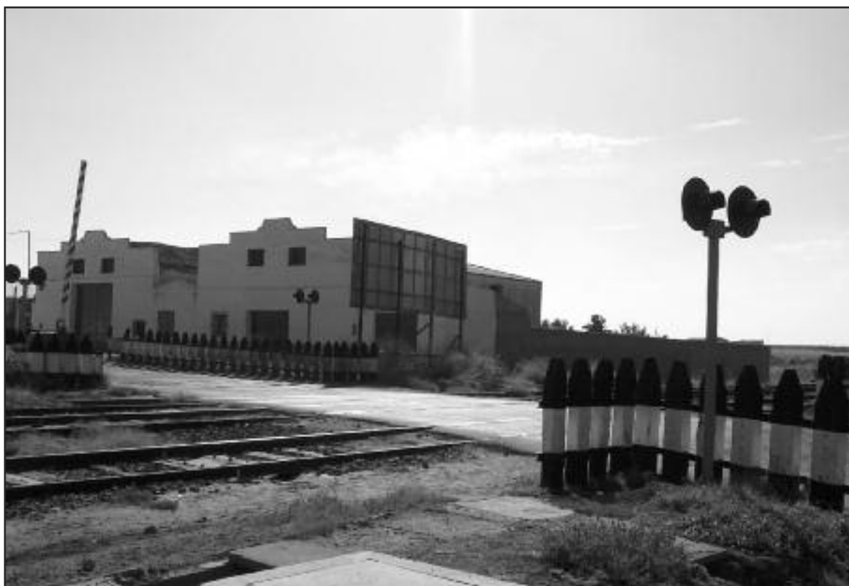
Paso a nivel de la carretera de Alange
