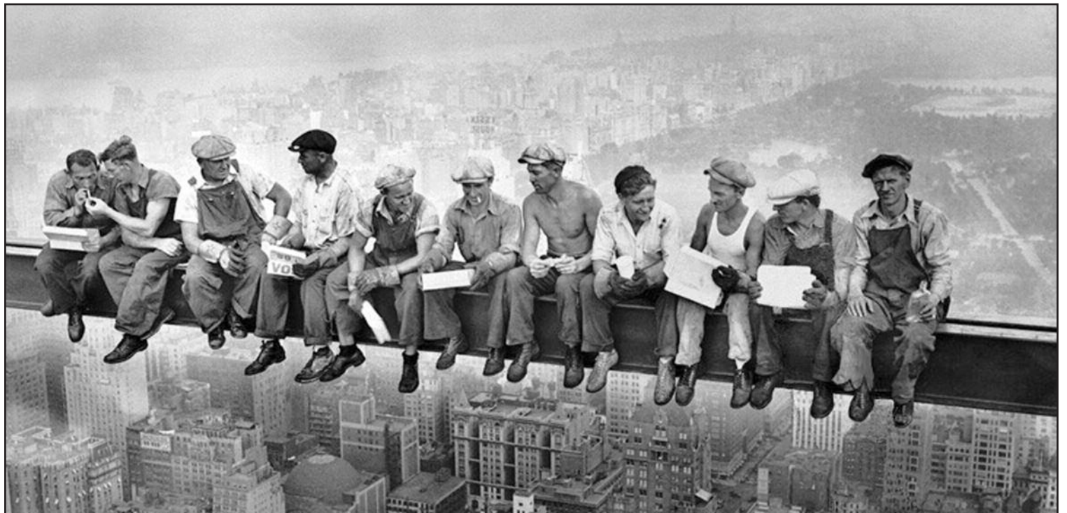
Charles C. Ebbets fotografió a once obreros almorzando a 244 m. de altura durante la contrucción del Rockefeller Center de Nueva York (1932)
