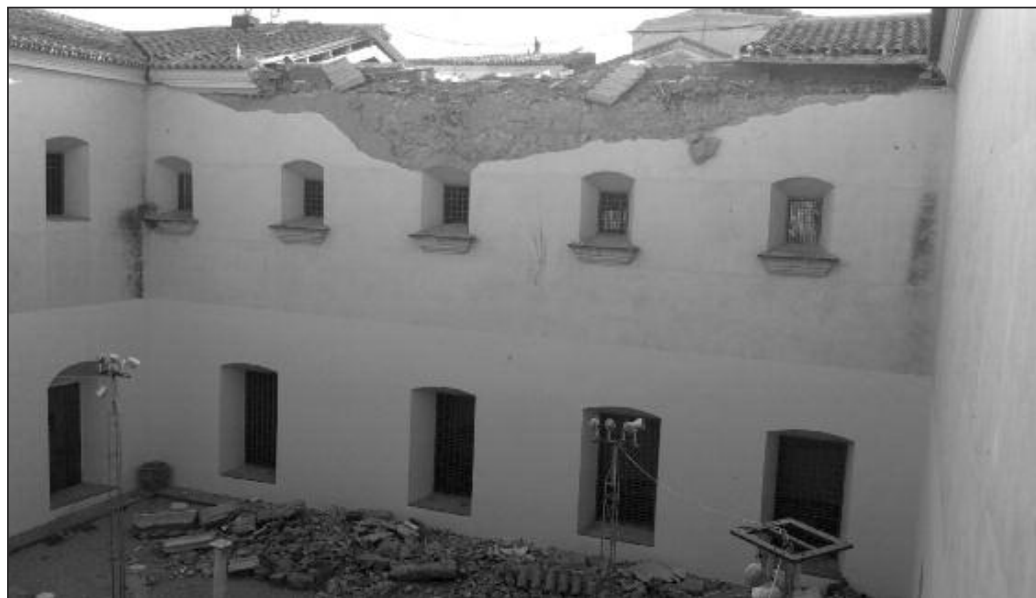
Vista exterior del estado de la cubierta y del patio
