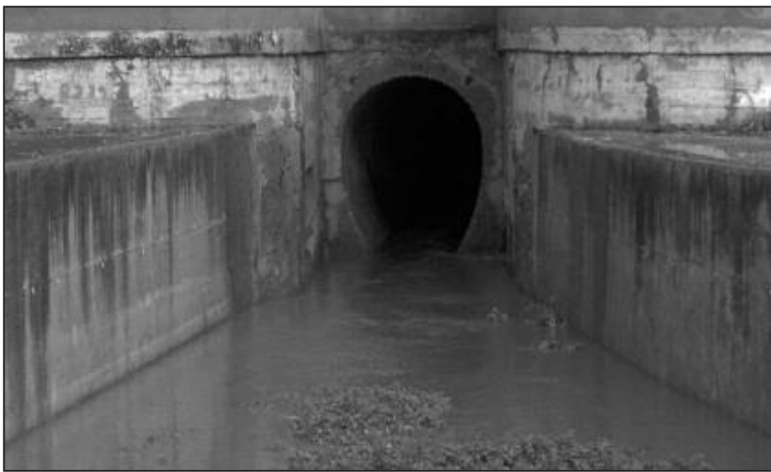
Entrada del Charnecal en el colector de aguas residuales
