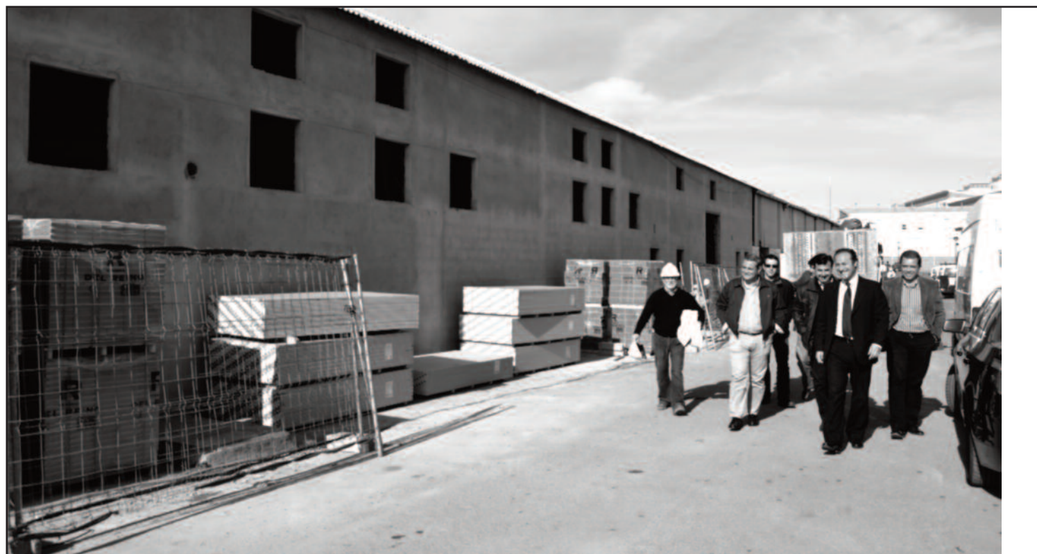
Visita del alcalde, concejales y técnicos a la obra del nuevo mercado
