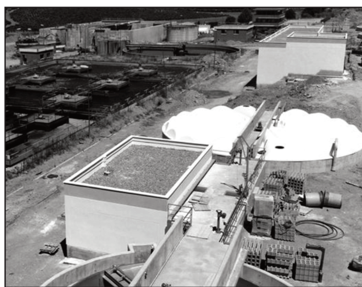
Obra de la nueva depuradora
