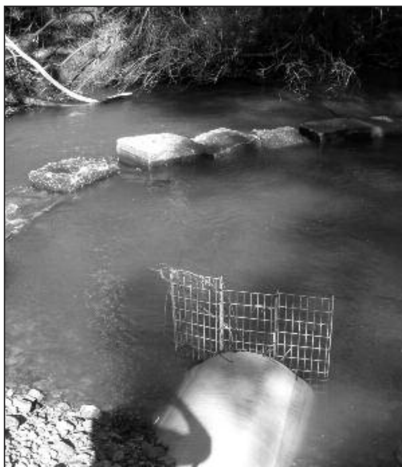
Nueva toma, en el río Matachel
