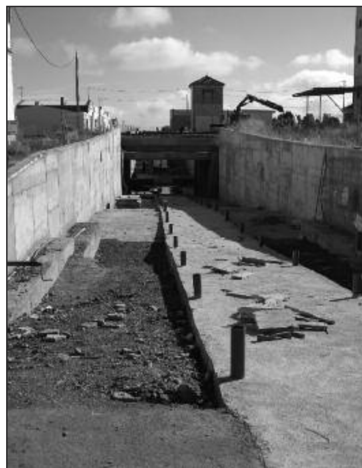
Construcción del acceso para peatones
