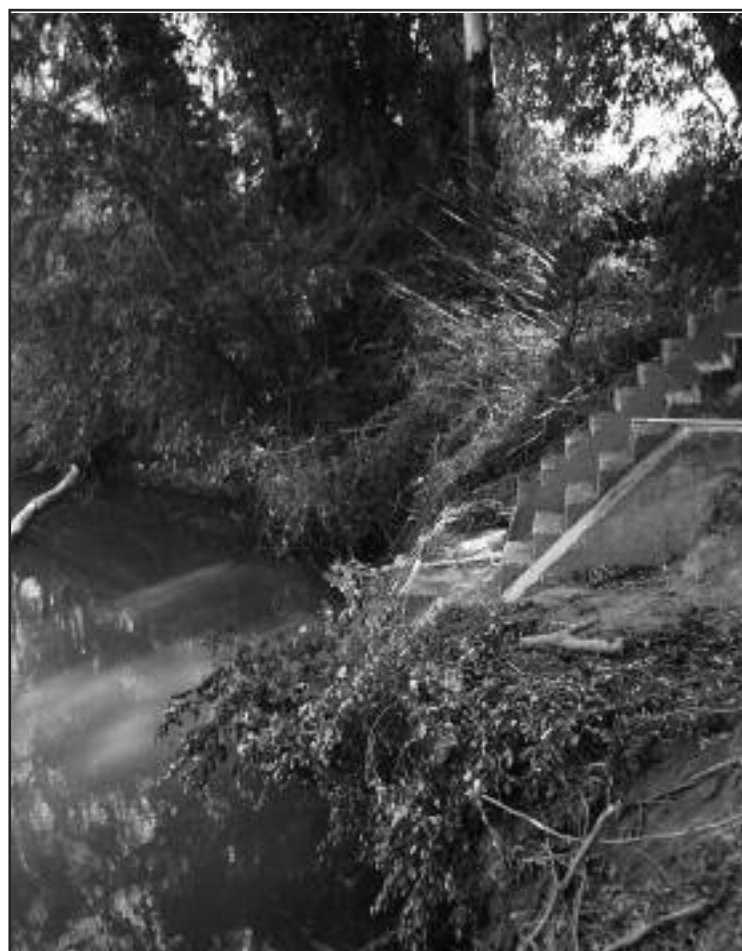
Captación de agua del Guadiana
