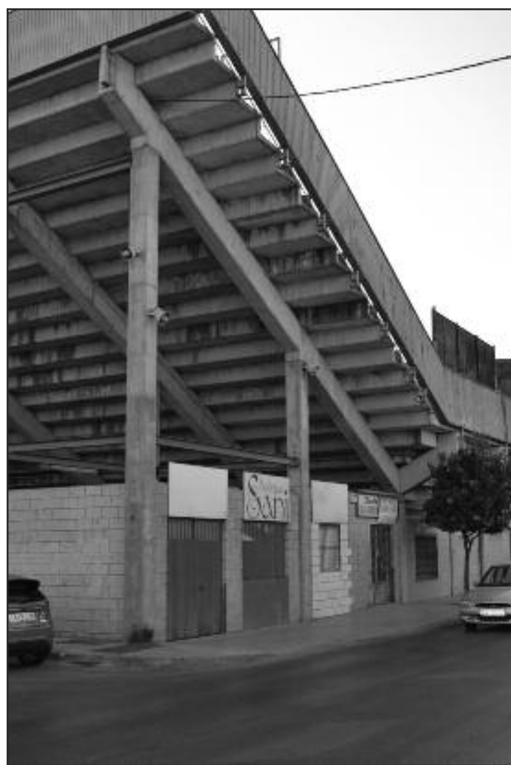
Se va a repintar la cerrajería y estructura del estadio
